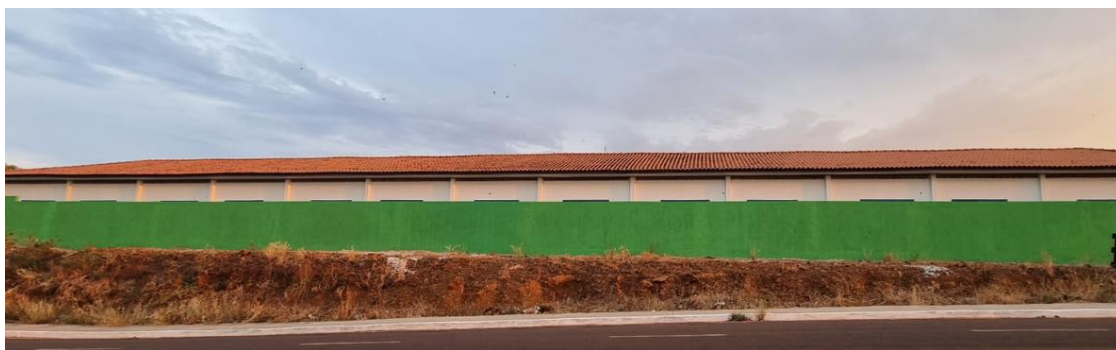
Figura 05 - Visão frontal de onde será instalado o sistema
