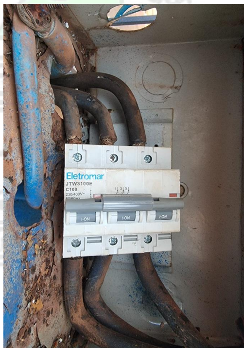
Figura 04 – Disjuntor do Padrão de Entrada
